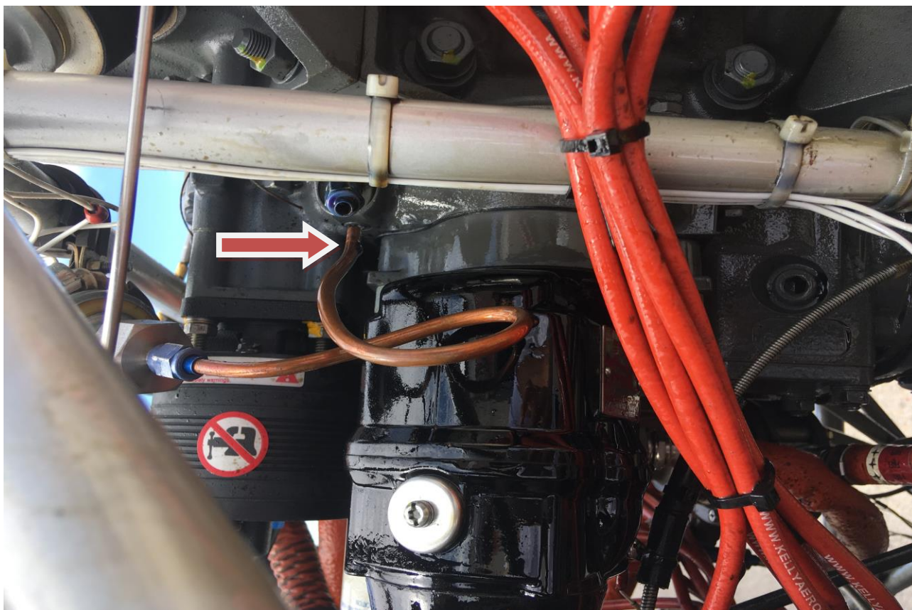
Rys. 1 - Widok urwanego przewodu olejowego [źródło: GSS AP Żar].
